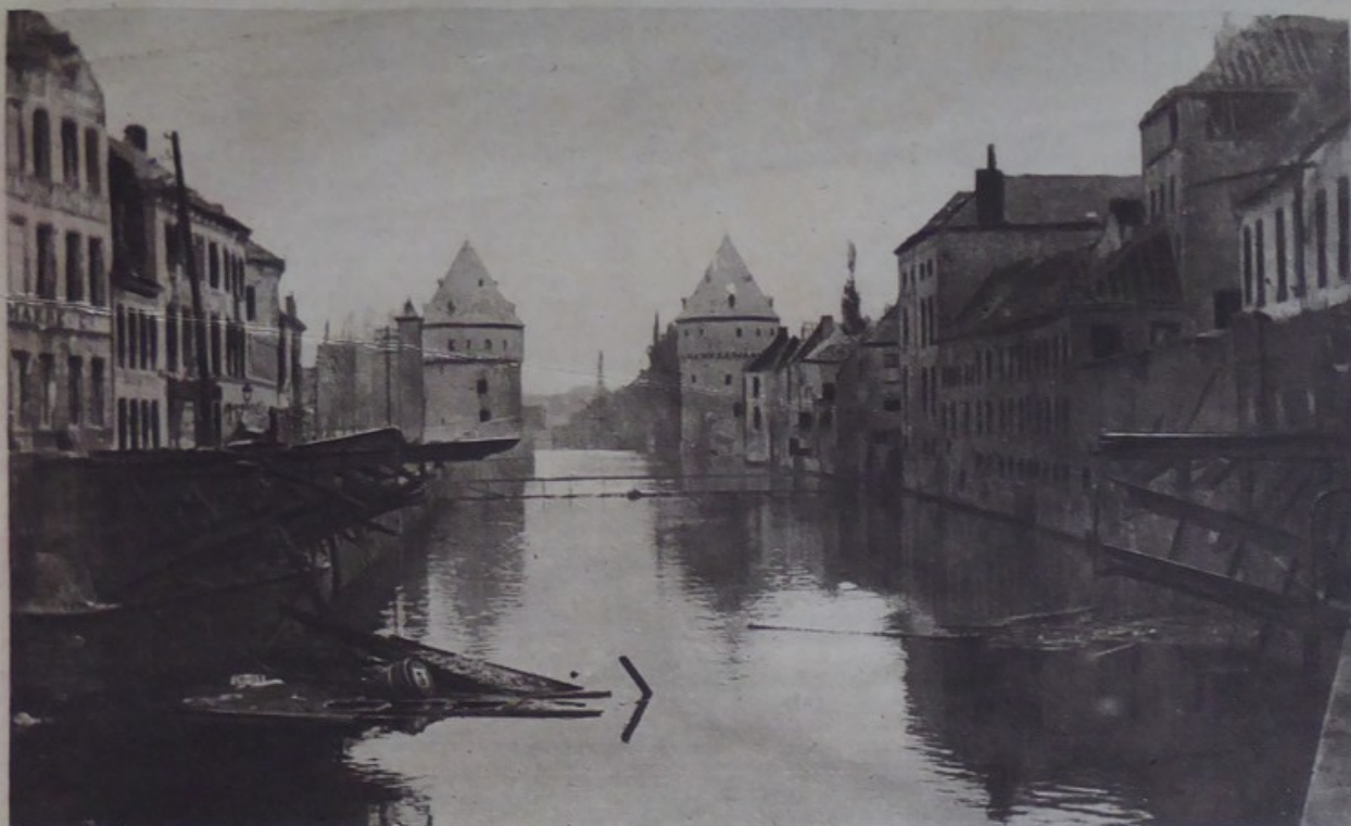
Entre ces deux tours trapues appelées « Tours du Broel », un pont, détruit par les Boches, passait par-dessus la Lys : elles sont vieilles de plus de cinq cents ans et faisaient partie d'une enceinte démolie sous Louis XIV. L'une d'elles, qui avait été convertie en musée d'antiquités locales, renfermait une riche collection de dentelles du pays. Il existe d'ailleurs à Courtrai un autre musée où l'on conservait des peintures dont quelques-unes sont célèbres.
