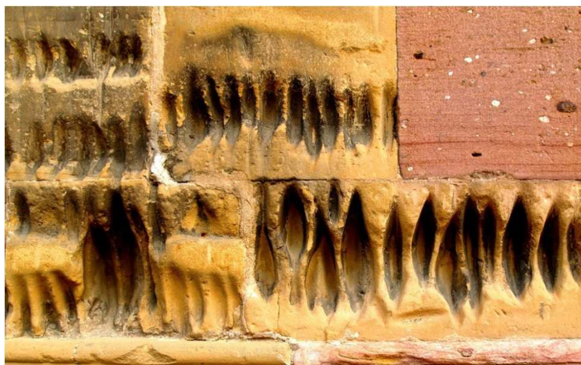
Mur de l'église Saint-Martin – XIII e siècle, à Pfaffenheim en Alsace.
