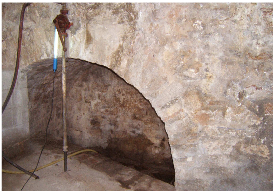
La fontaine existe toujours dans la cave d'une maison particulière. Avec l'aimable autorisation de Monsieur Loïc Larher, l'ancien propriétaire. (Photo Marc Galludec)
