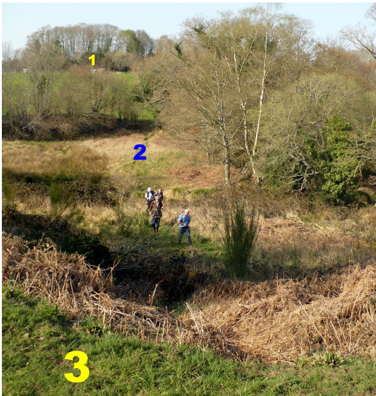
Fig.24 : La chaussée-digue de Hent Coz, reliant la motte de Quimerc'h au plateau du Raquériou : La vue a été prise de l'angle nord-est de ce plateau (cf Fig.16). L'amont est à gauche. L'aval à droite est masqué par une rangée d'arbres implantée sur un reste de talus surmontant ce côté de la digue.
