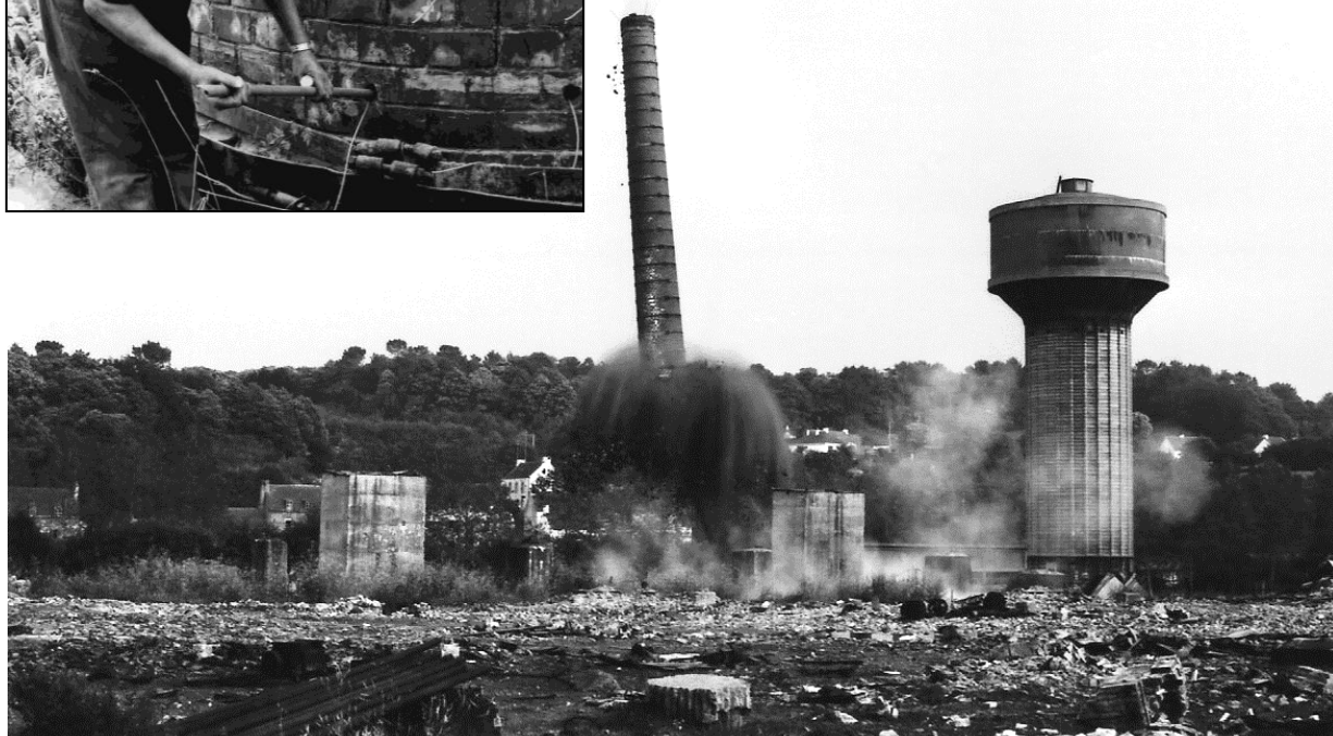
L'artificier dû s'y prendre à deux fois pour dynamiter la cheminée.
