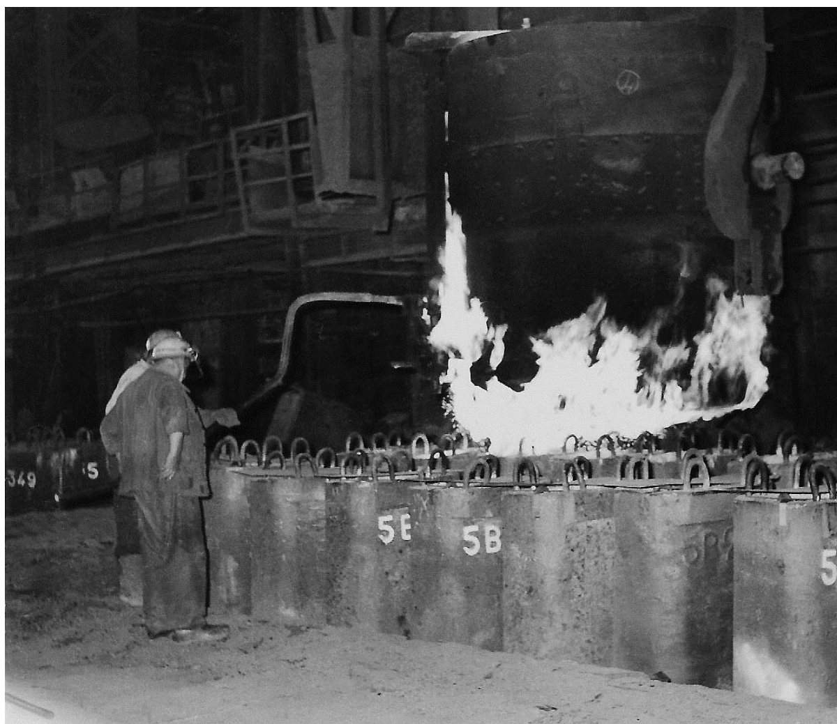
Une coulée pour la fabrication des "lingots".
